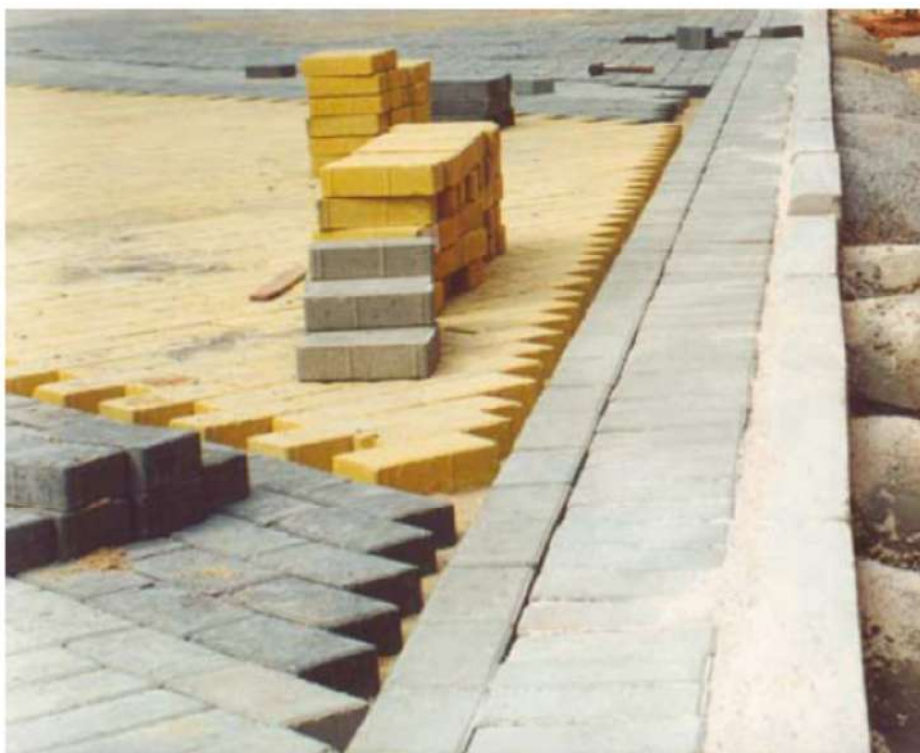
FIGURA 5 - Confinamento externo (guias)
