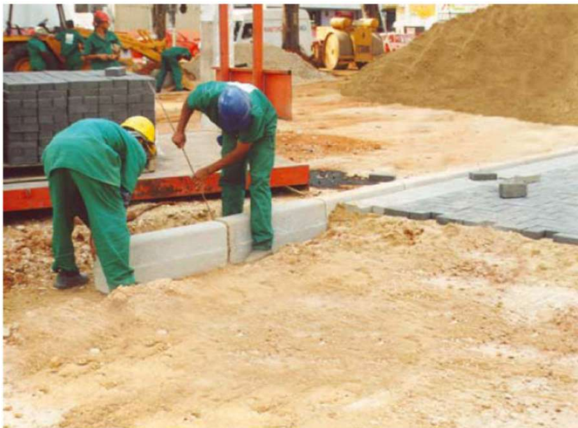
FIGURA 3 - Colocação de confinamento externo (meio-fio)
