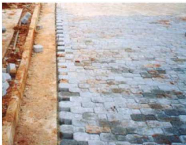
FIGURA 4 - Confinamento externo (meio-fio)
