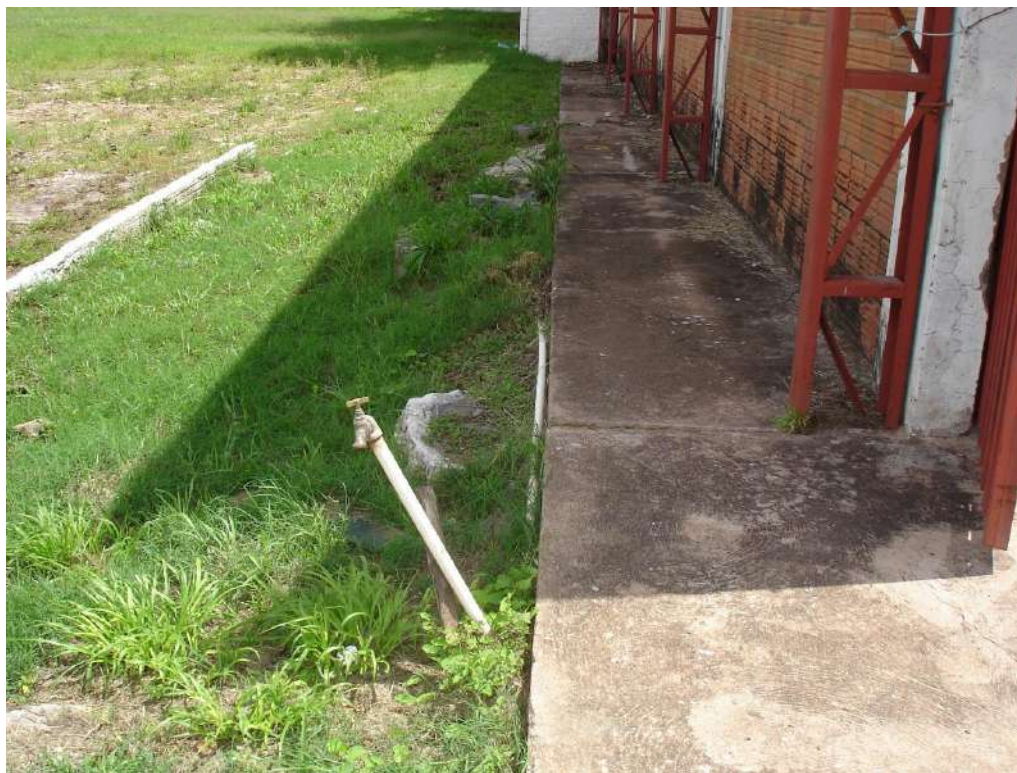
Figura 12: Lado externo, torneira de uso geral (acervo Infraero)
