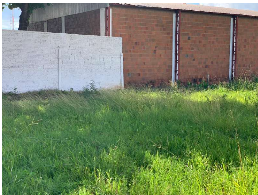
Figura 8: Fachada lateral direita (acervo Infraero)
