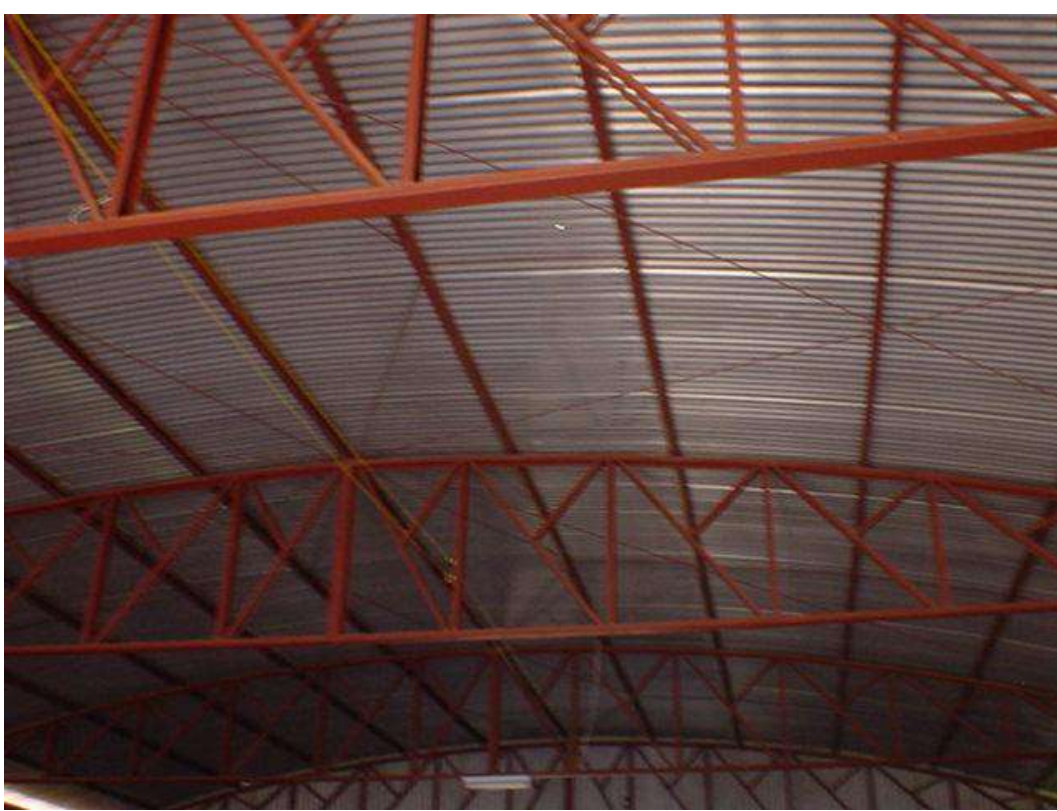
Figura 11: Estrutura metálica de sustentação da cobertura (acervo Infraero)
