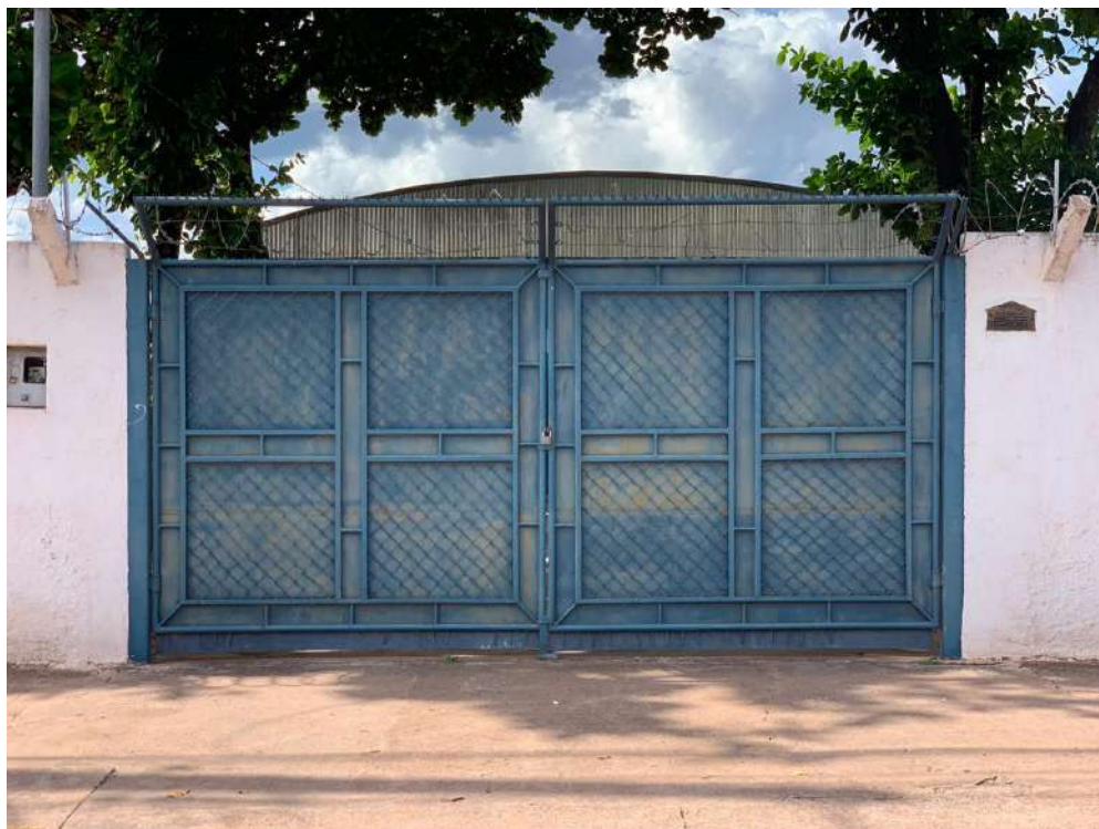
Figura 4: Vista frontal do Hangar CR6RHG000001, tomada na Rua Santos Dumont (acervo Infraero)
