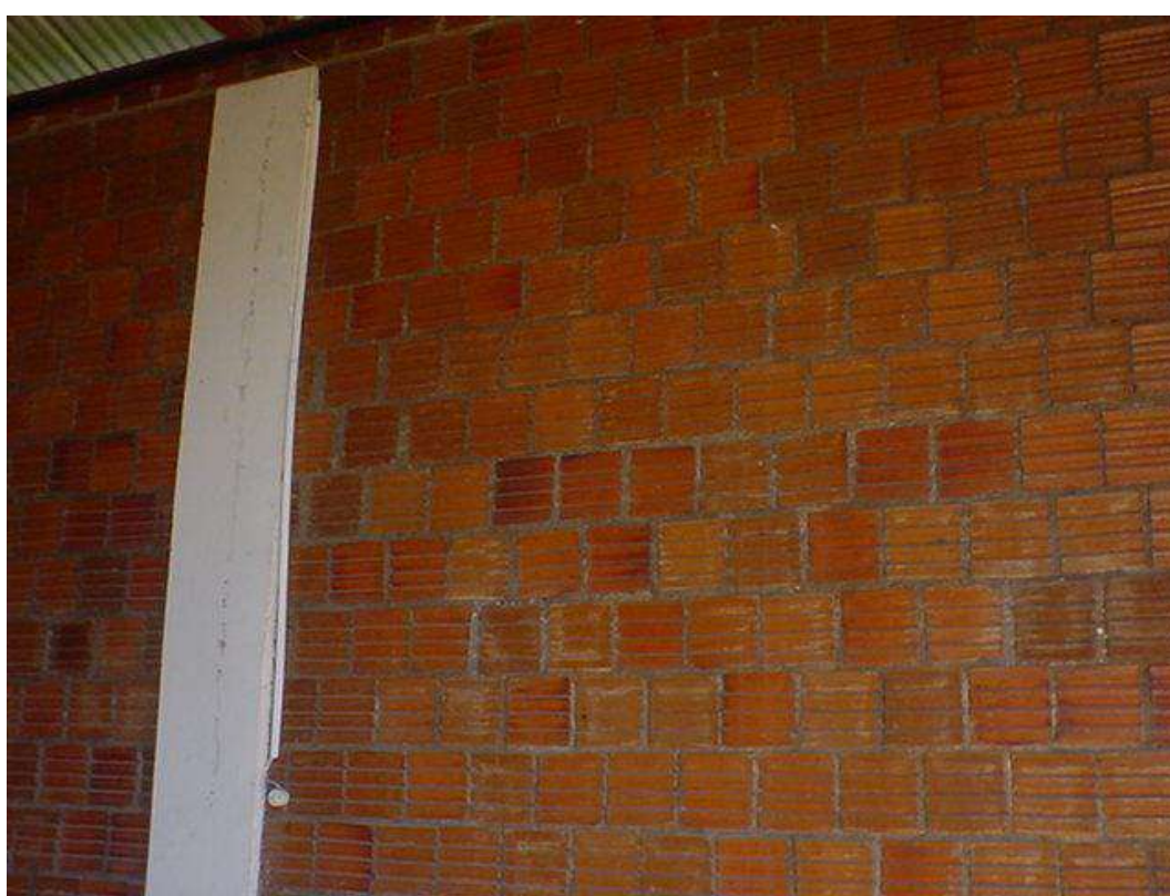
Figura 10: Interior da edificação (acervo Infraero)
