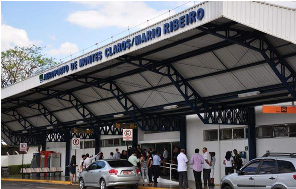
Figura 05 – Fachada Lado Terra do TPS SBMK. Fonte: Oliveira, 2017.
