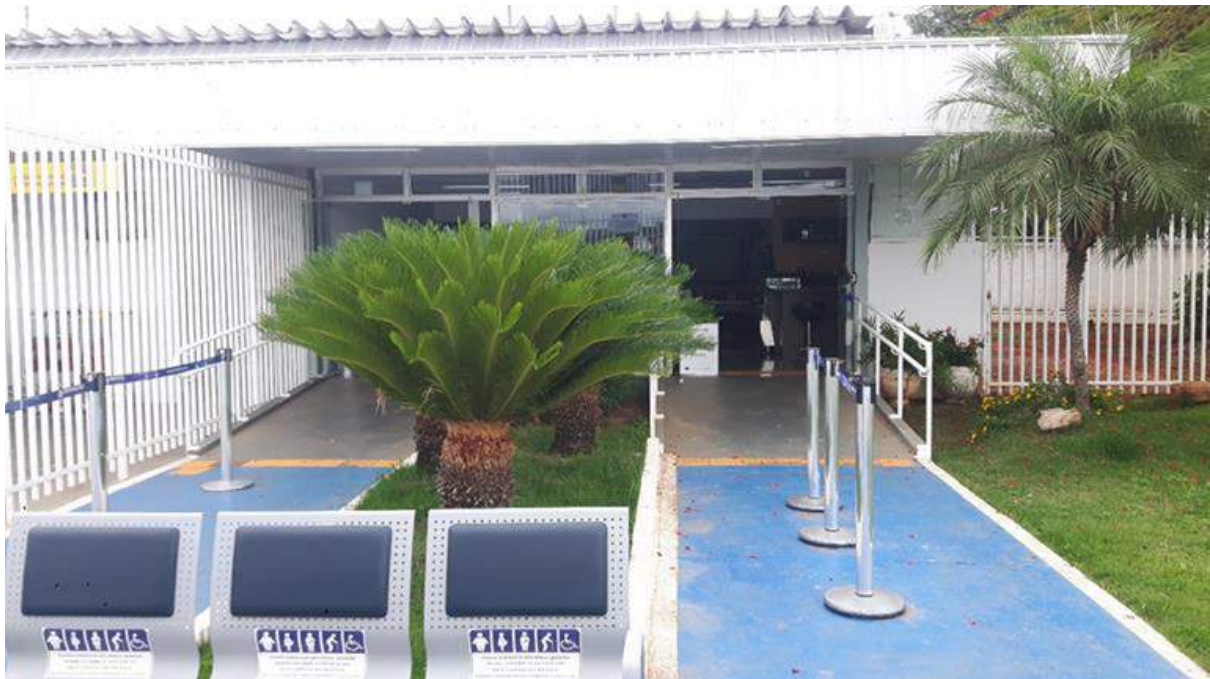
Figura 12 – Fachada lado ar da sala de embarque do TPS SBMK. Fonte: INFRAERO, 2018.
