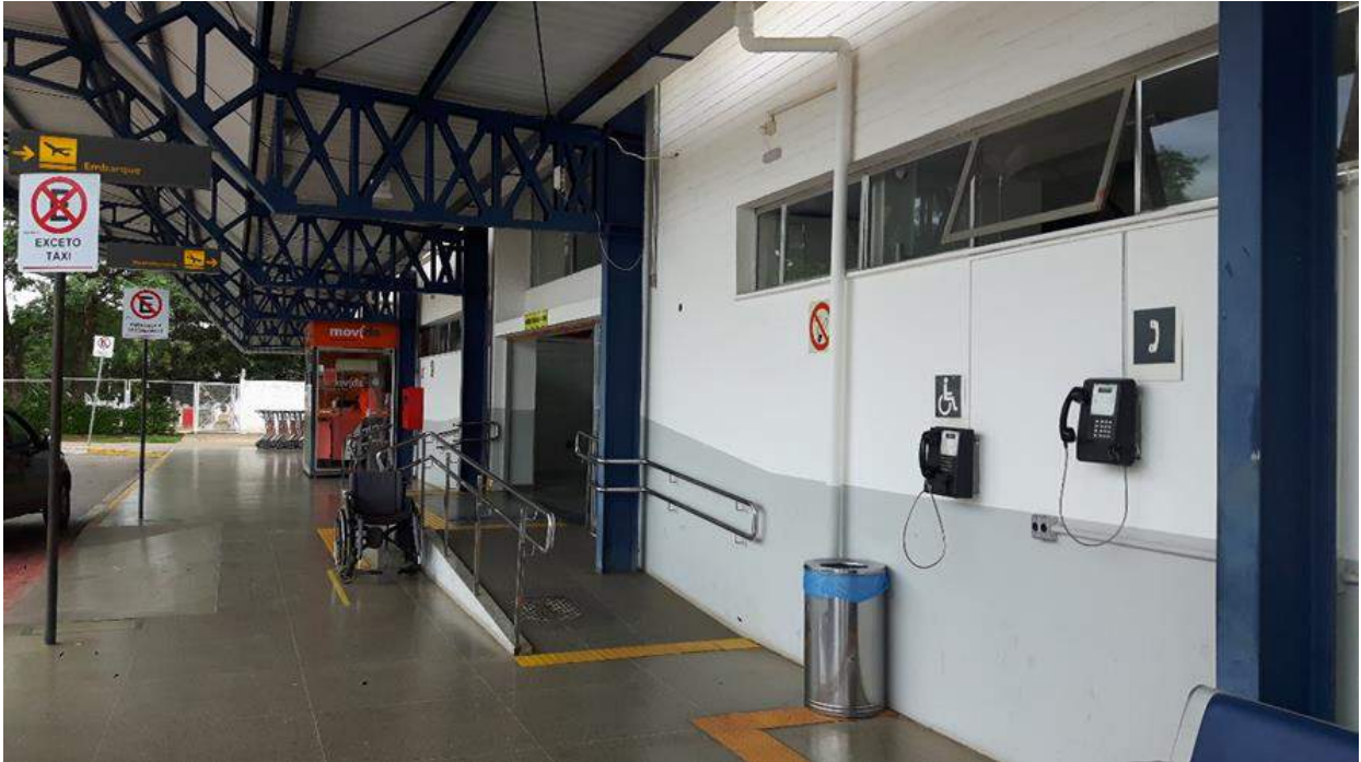
Figura 07 – Rampas de Acesso ao TPS SBMK. Fonte: INFRAERO, 2018.
