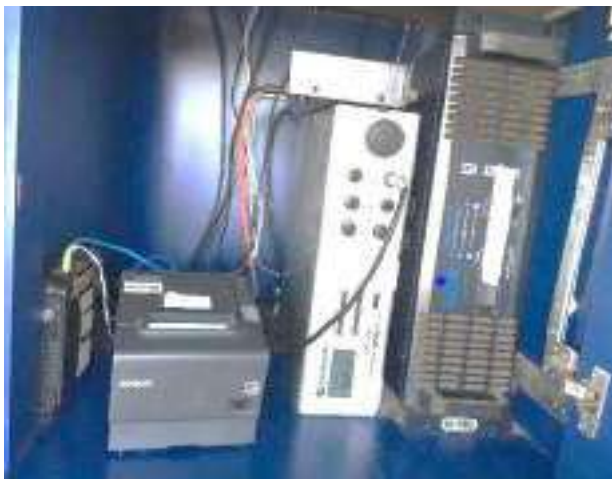
Figura 5 – Receiver e Amplificador (UAR da Azul)
