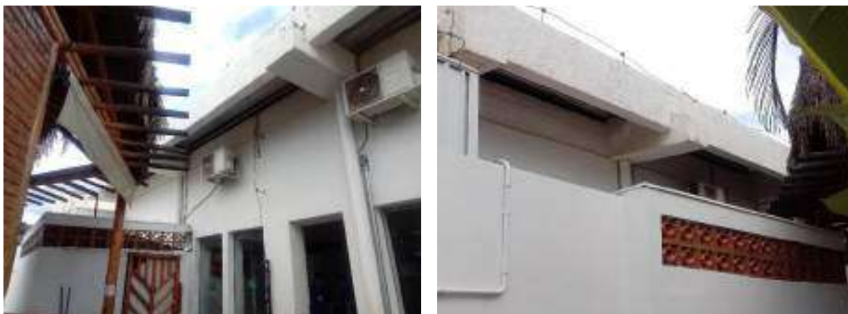
Figura 5 - Detalhe das vigas de contorno do telhado na região do quiosque. Os apoios destas vigas são efetivados por vigas calhas de maiores larguras mostradas nas fotos.
