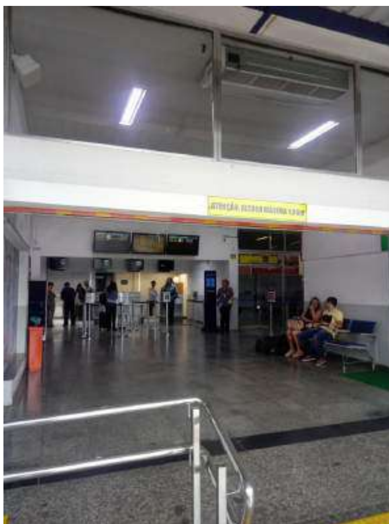
Figura 9 - Acesso principal ao TPS. Pé direito de 1,96 repete-se sob todas as vigas e portas do terminal.
