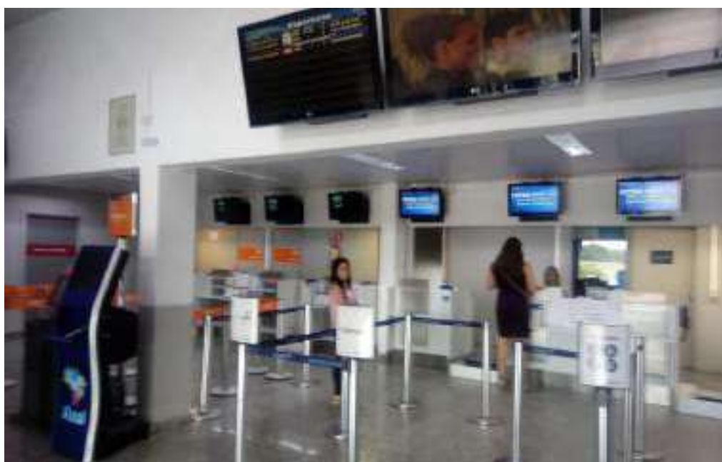
Figura 7 - Check in. Notar a viga onde estão instalados os monitores. Pé direito sob as mesmas de 1,96 m. Pé direito sob o forro em PVC de 2,30 m.
