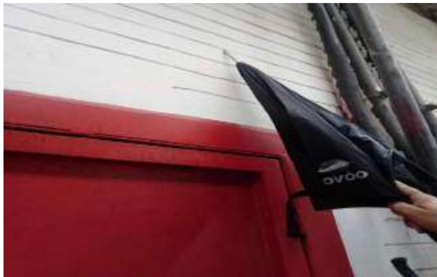
Figura 11 Porta corta fogo. A ponta do guarda chuvas marca o limite superior da viga de concreto onde esta inserida a referida porta. Foi necessário o corte da metade inferior da viga para instalação da mesma.
