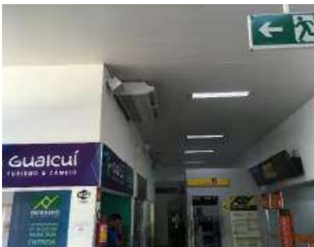
Figura 7 – Sonofletores no saguão
