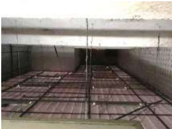
Figura 9 – Cabos distribuídos sobre o forro
