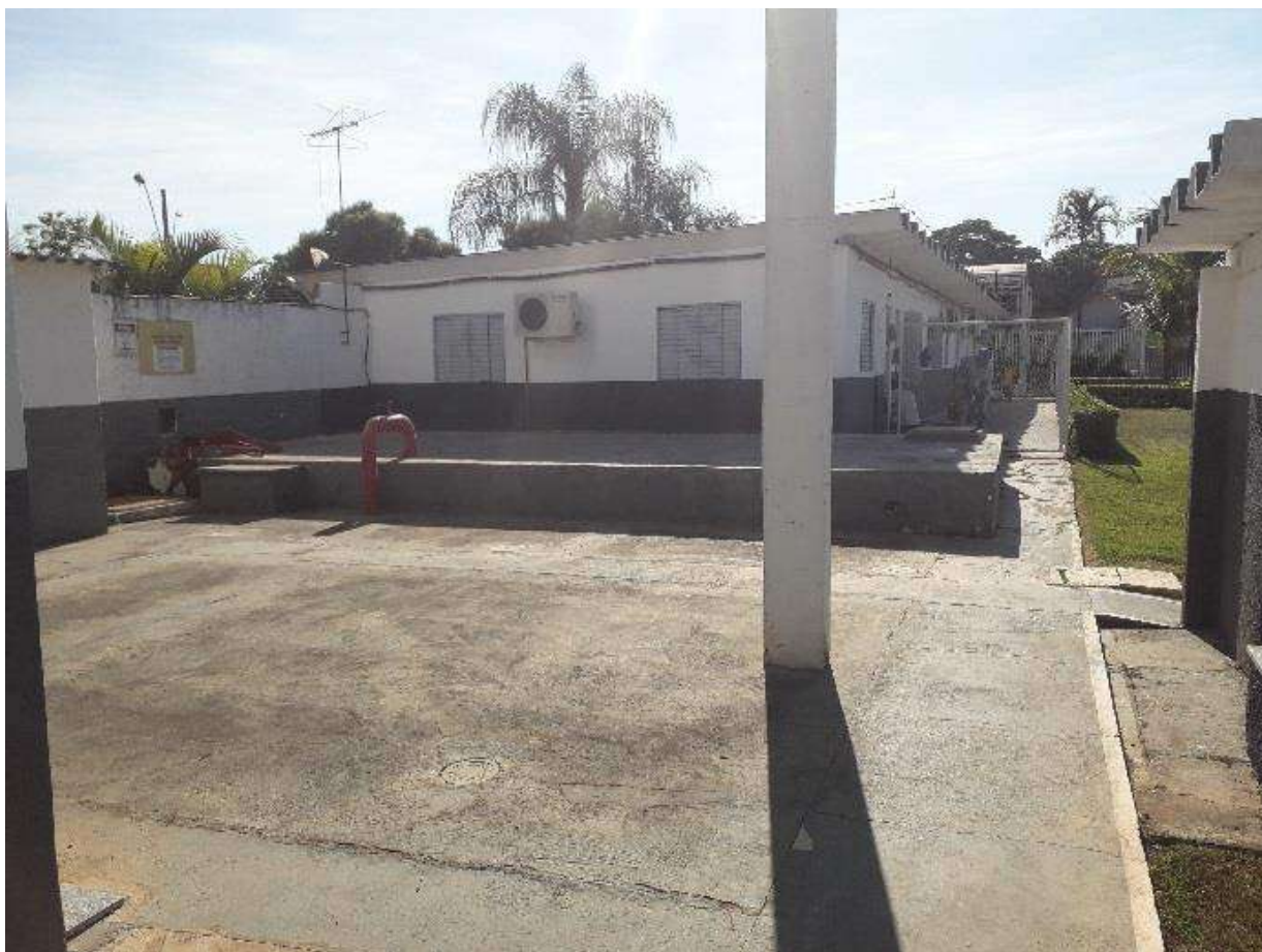
Figura 01 – Sistema de água fria existente do TPS e Conjunto motor-bomba do sistema de abastecimento (Março/2019).
