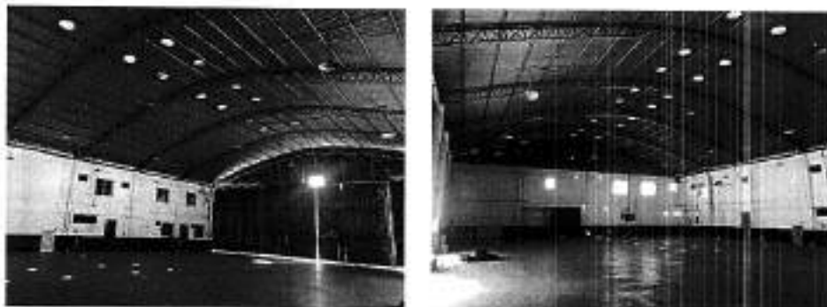
Fotos 08 e 09: Interior do Hangar 33.
