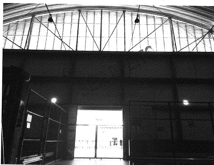
Figura 4 – Vão de abertura TECA 3, com esquadrias em veneziana de aço e gradil metálico com brises para fechamento do arco da cobertura
