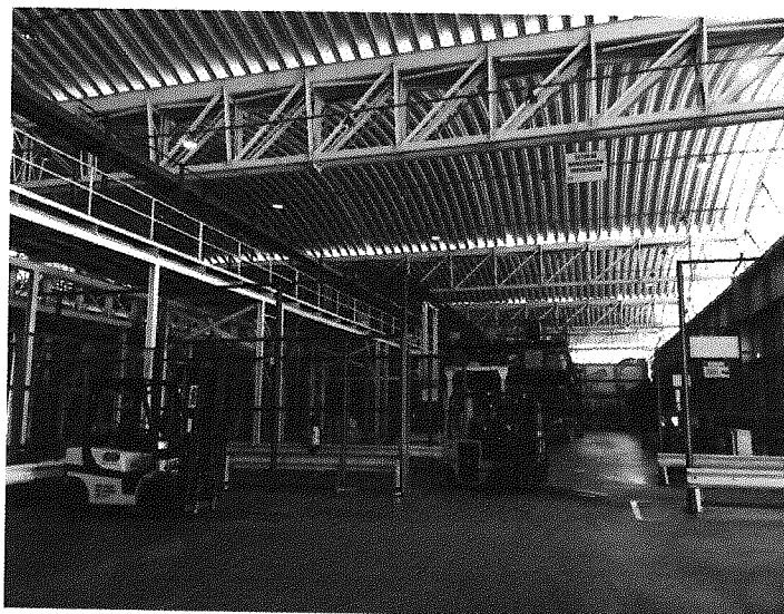
Figura 3 – Galpão do TECA 3, subdividido com gradis, cobertura com estrutura metálica e telhas curvas autoportantes
