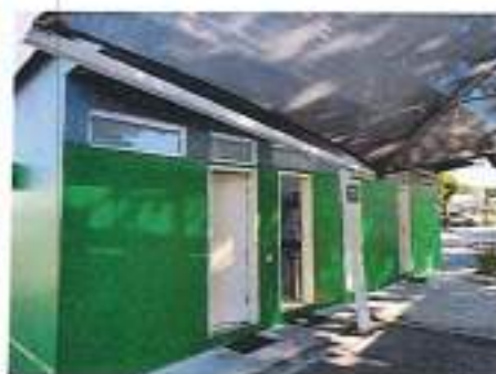
Figura 08: Edificação de apoio.
