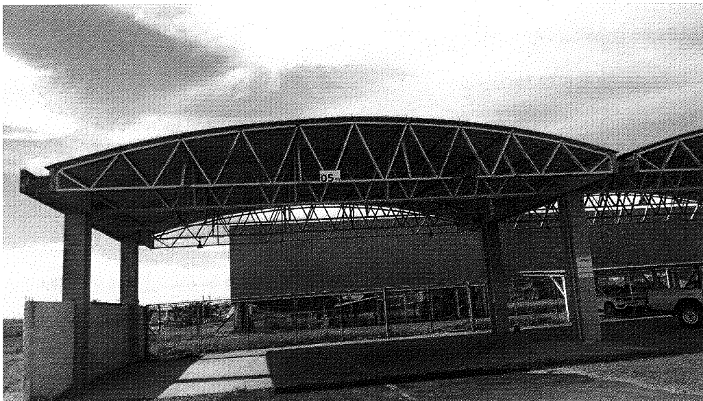
Área a ser licitada – Hangarete nº 05
