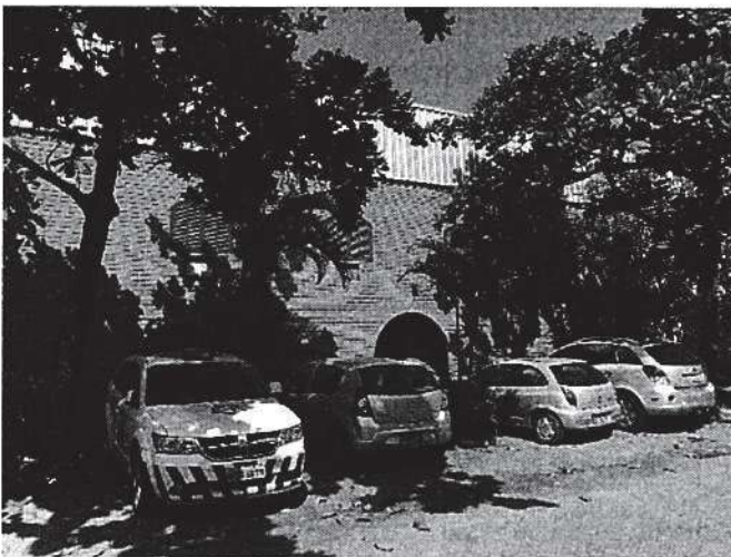
Foto 02: Fachada do Hangar 07.
