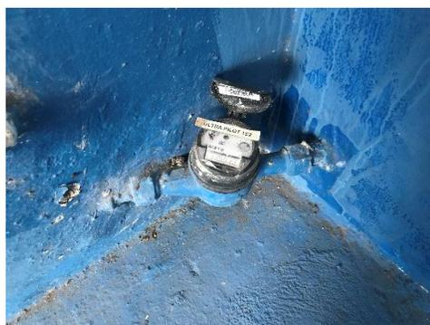
Foto 01: Hidrômetro do Prédio 72 E e Hangar 73.
