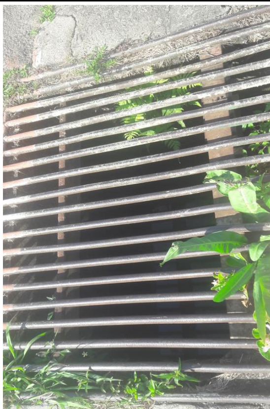
Detalhe da drenagem
