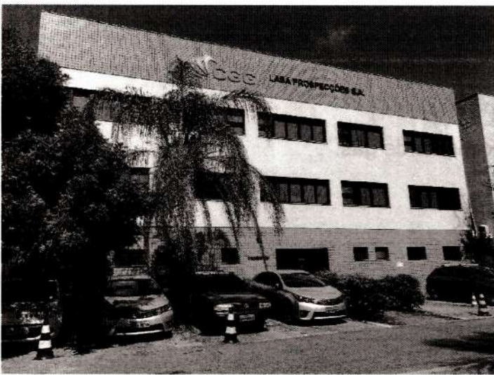
Foto 05: Fachada do Hangar 39.
