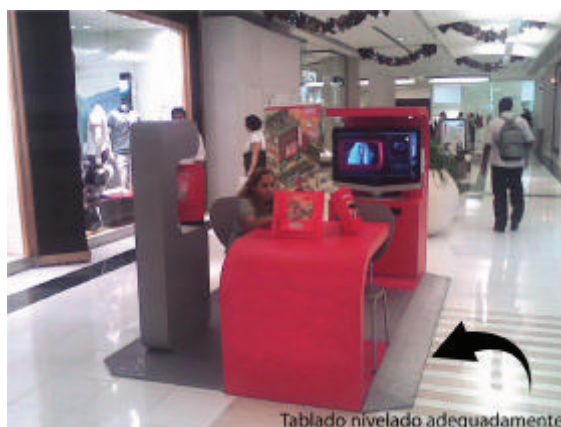
EXEMPLO DE QUIOSQUE COM DESNÍVEL ADEQUADO, (nivelado ao piso do saguão com uso de rampa)
