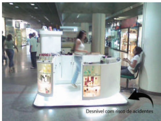
EXEMPLO DE QUIOSQUE COM DESNÍVEL INADEQUADO, OCASIONANDO RISCO DE ACIDENTE.
