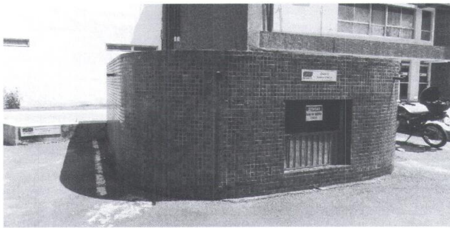
TECA I – Casa de Bombas
