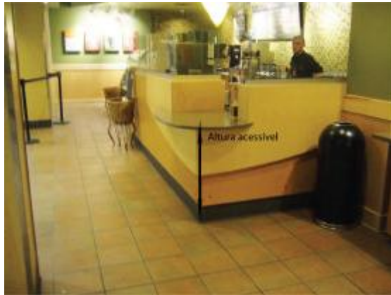
EXEMPLO DE QUIOSQUE COM ALTURA ADEQUADA E ACESSÍVEL
