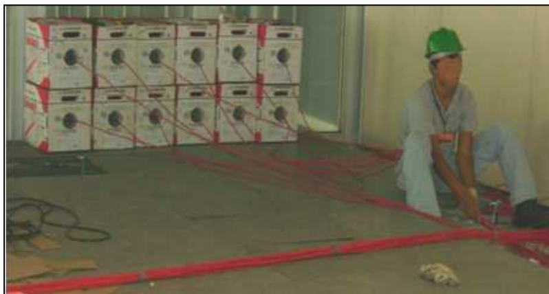
Figura 37 – Método de Lançamento de Cabos.
