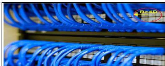
Figura 19 - Raio Mínimo de Curvatura para Cabo UTP.
