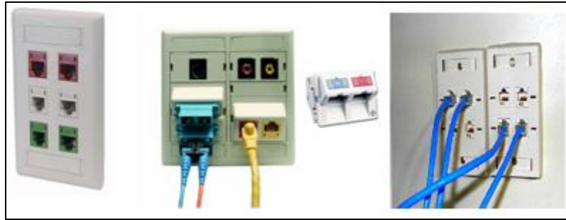
Figura 1 – PoT's com Tomadas de Telecomunicações (ToT's).
