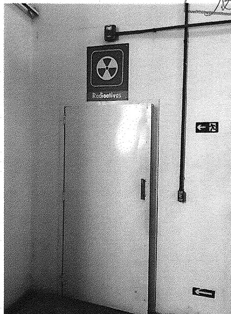
Figura 14 – Porta do tipo corta fogo para acesso ao depósito de radioativos
