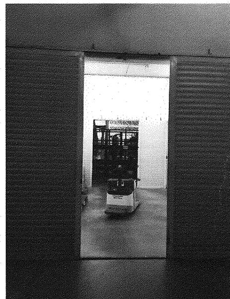
Figura 12 – Porta metálica tipo veneziana interligando os ambientes do depósito de cargas
