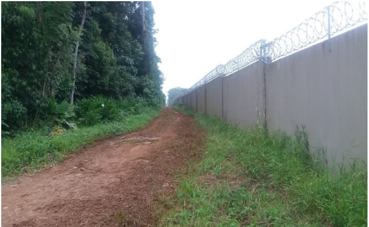
Figura 03: Via de acesso e muro perimetral do SBJV na face frontal do terreno a ser concedido.
