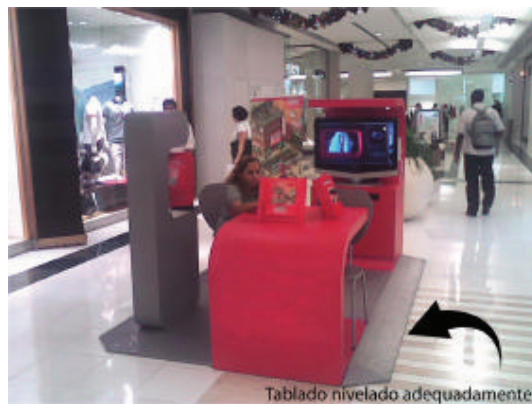
EXEMPLO DE QUIOSQUE COM DESNÍVEL ADEQUADO, (nivelado ao piso do saguão com uso de rampa)
