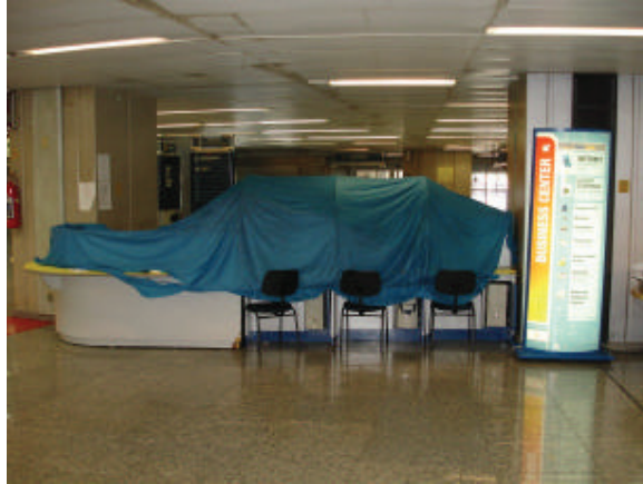
EXEMPLO DE FECHAMENTO INADEQUADO
